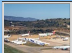
Aeropuerto de Castellón a 20'
